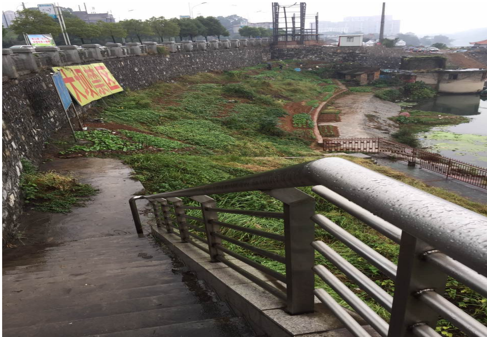
图 11 第 8 处警示 标志 “大坝 禁区”
