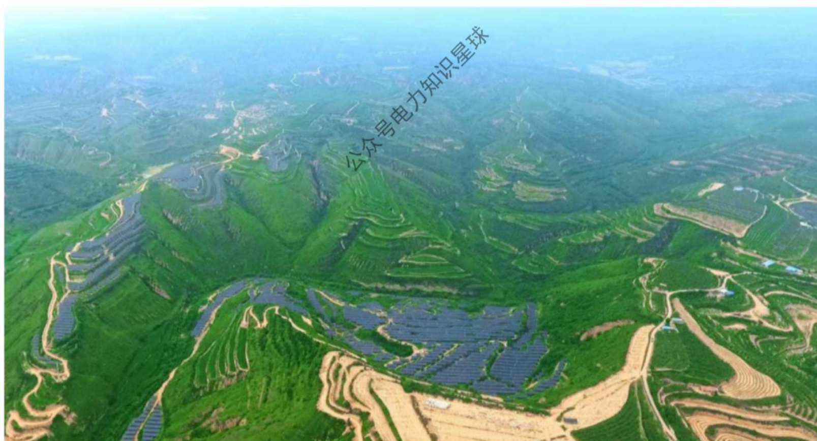
图 4.1 山地光伏电站
